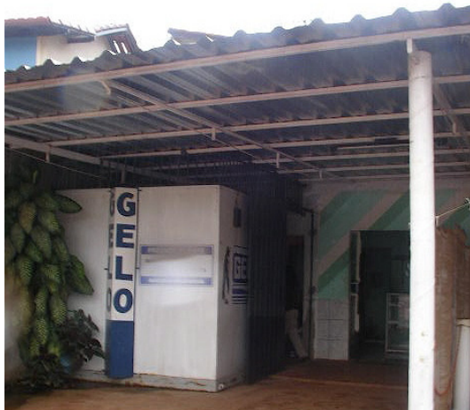
6. Unidade de fabricação de gelo e “freezer” de estocagem
