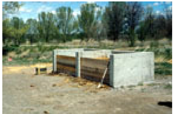
12. Caixas para a compostagem de peixe proveniente de mortandades, em sistema de 2 estágios, em Buhl, Idaho.
