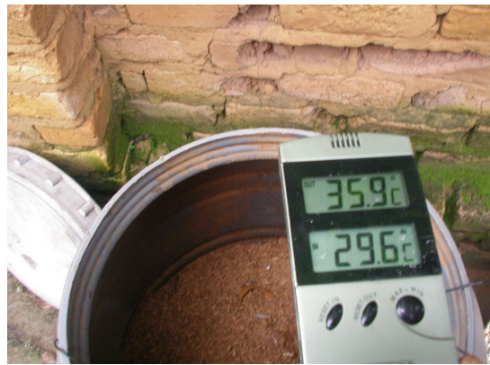
10. No prazo de dois dias, houve uma elevação de 6°C na temperatura interna.
