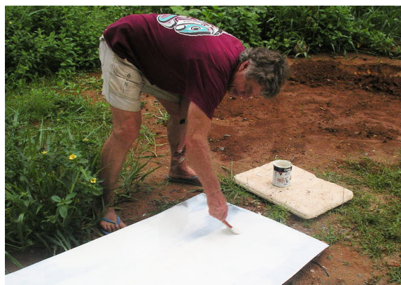
4. Aplicando demão de fundo na placa da câmara solar
