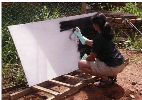
5. Aplicando tinta preta na placa da seção coletora, para aumentar a absorção de calor
