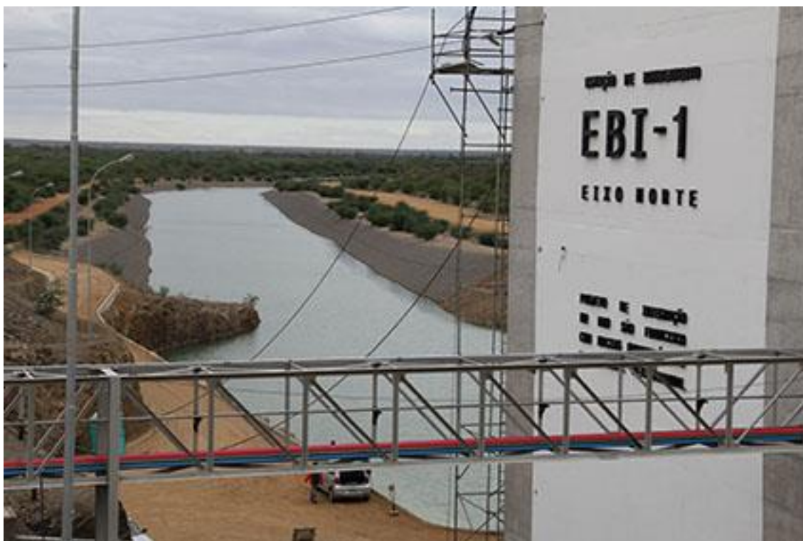
Fotografia 34: Imagem Usina de Bombeamento EBI-1 e canal do Eixo Norte após abertura do canal.
