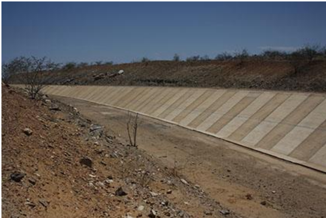
Fotografia 28: Imagem canal do Eixo Norte. Município de Cabrobó (PE).
