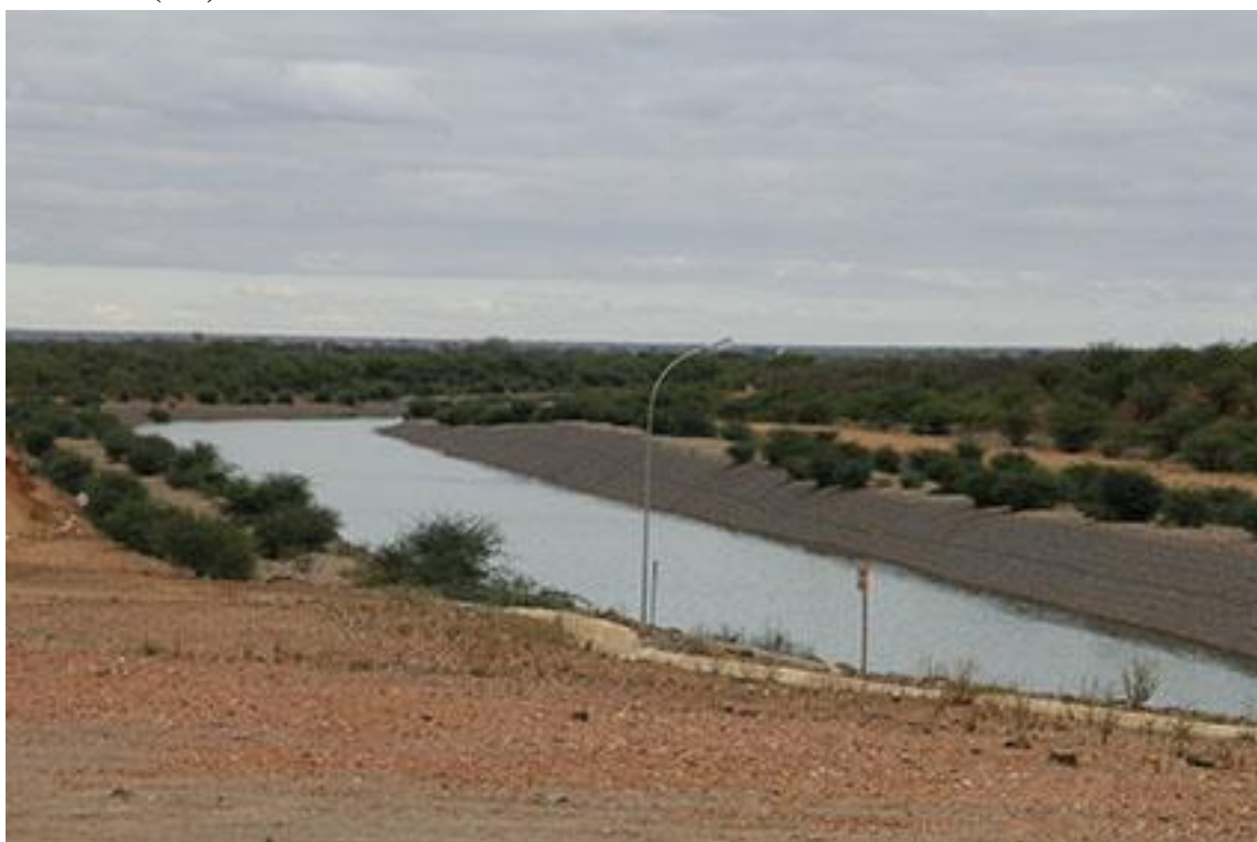
Fotografia 31: Imagem canal do Eixo Norte, trecho 01 finalizado. Município de Cabrobó (PE).
