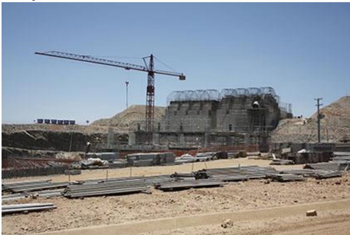
Fotografia 32: Imagem construção Usina de Bombeamento EB1. Eixo Norte. Município de Cabrobó (PE).
