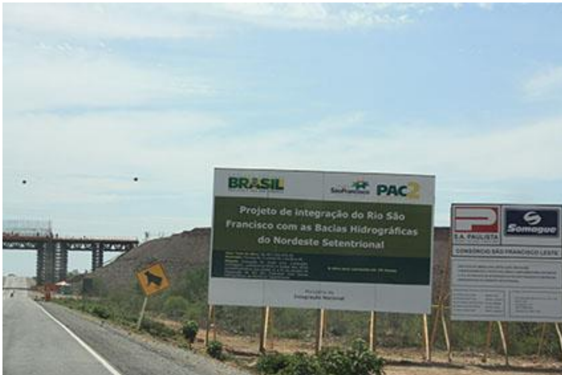
Fotografia 26: Imagem da construção do Eixo Leste no município de Floresta (PE).
