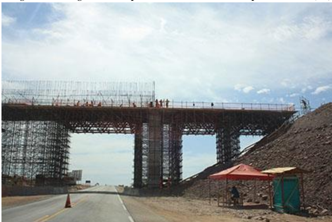
Fotografia 27: Imagem Ponte Aqueduto do Eixo Leste. Município de Floresta (PE).
