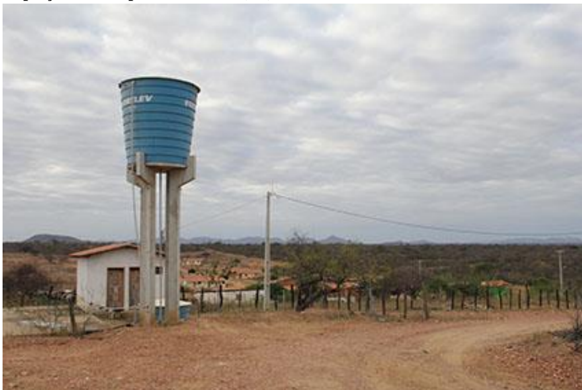
Fotografia 37: Imagem caixa d'água para abastecimento da Vila Produtiva Rural Captação. Município de Cabrobó (PE).
