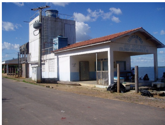
Figura 8. Vista da fábrica de gelo da Colônia de Pescadores Z-53, município de Breu Branco.
