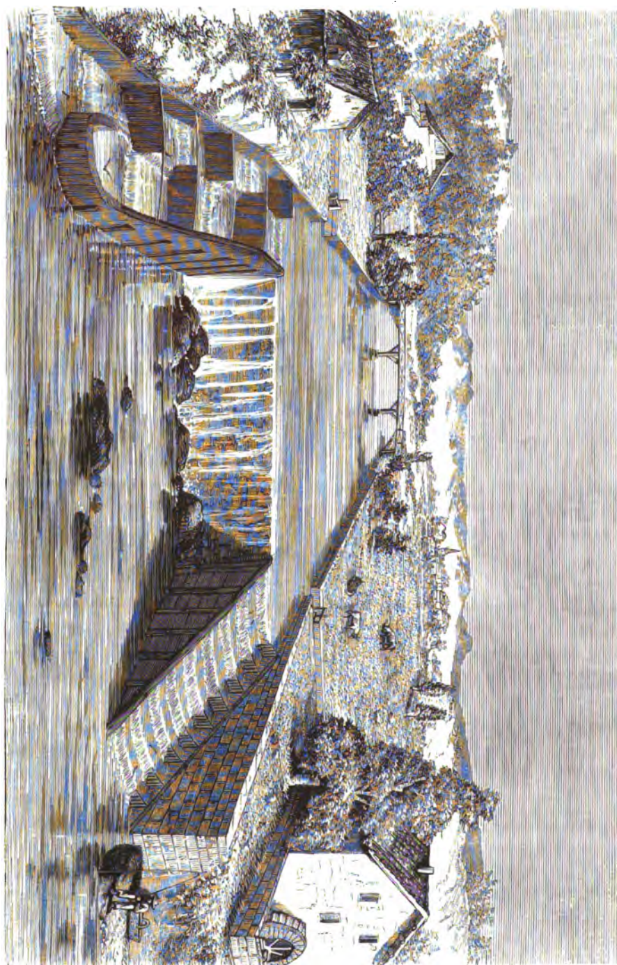
Figura 44.—Moldes de escalas salmoneiras usadas en los rios de Escocia, para facilitar la subida a los peces en las represas y saltos de agua.
